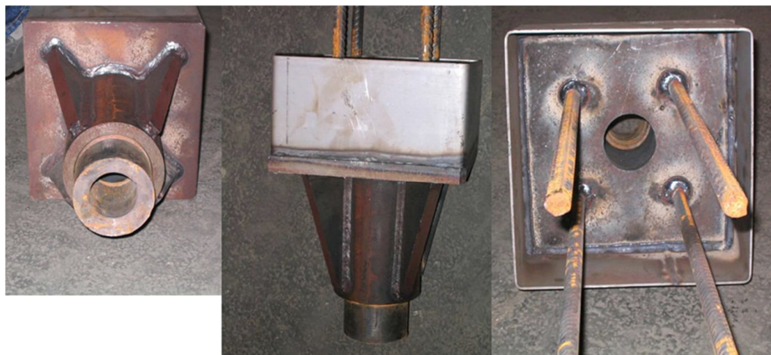
Figur 6.35 Foton som visar hur en bergsko med borrhörsdubb kan se ut.
