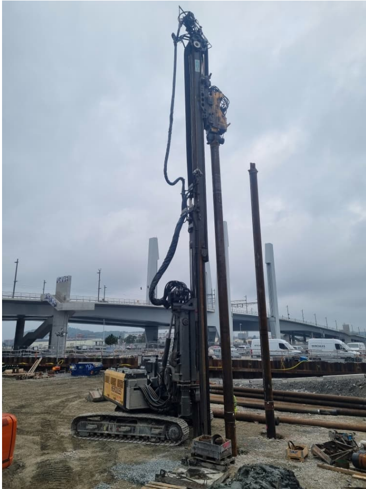
Figur 3.48 API spontmaskin anpassad för att vibrera pålar.
