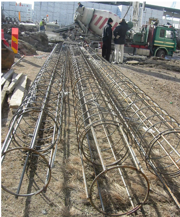
Figur 3.44 Installation av CFA-påle, Halmstad.
