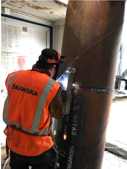
Figur 3.22 Skarvning av grov stålörspåle med svetsning.
