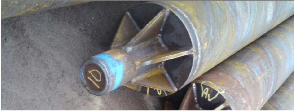
Figur 3.24 Stålrörspåle med bergsko och dubb av konstruktionsstål.
