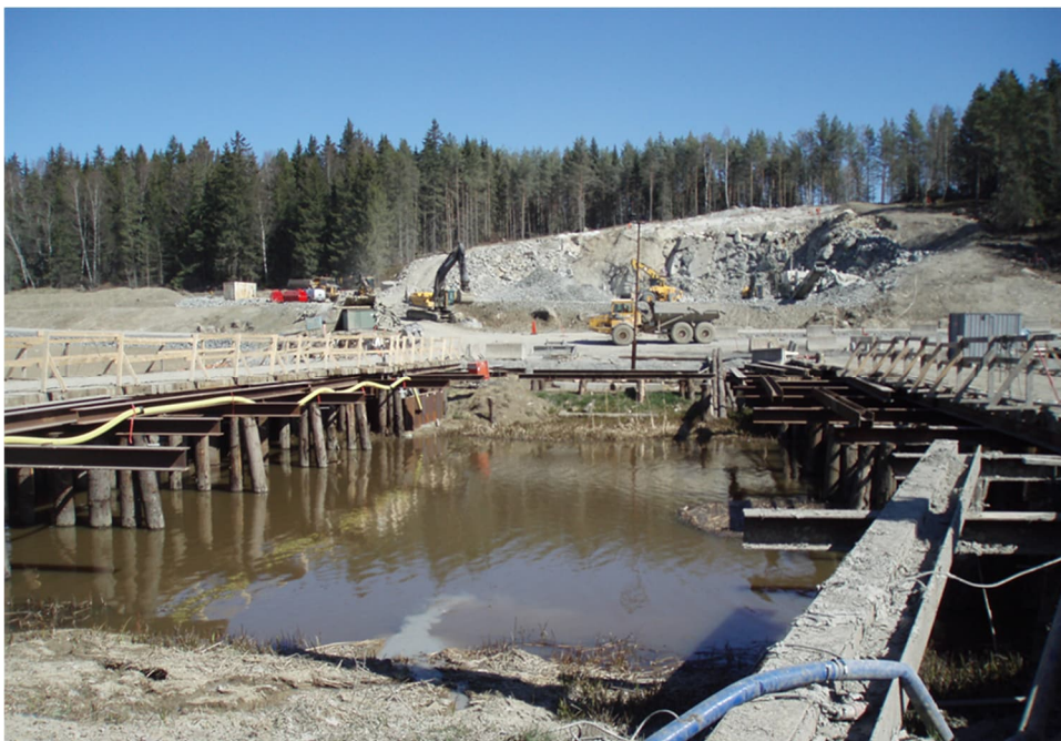
Figur 3.18 Exempel på temporär pålbrygga.
