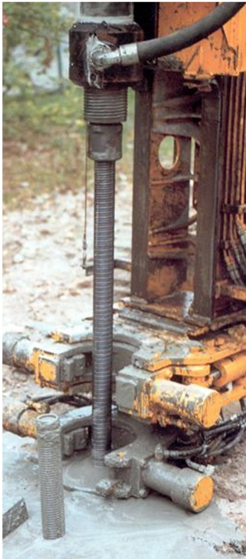
Figur 3.41 Installation av borrard injekterad påle utförs under kontinuerlig injektering av cementbruk. Injektionsstryck och tillförsel av cementbruk styrs för att erhålla en betongkropp runt stålpålen.
