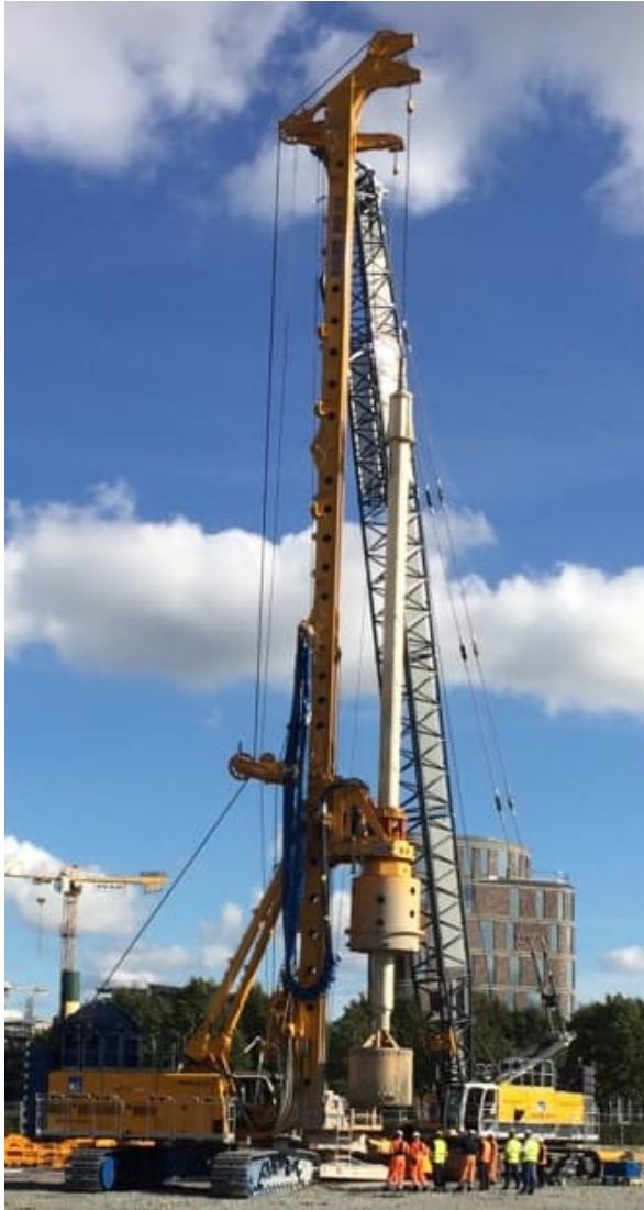
Figur 3.43 Borrutrustning för installation av grävpålar för Karlatornet, Göteborg.
