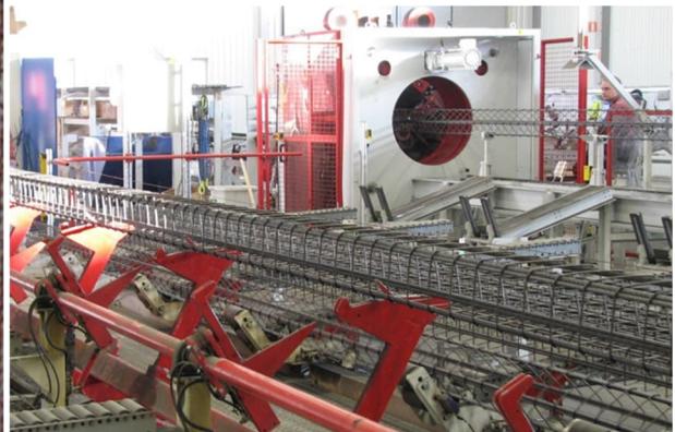
Figur 3.15 Svetsad armeringskorg intill svetsrobot.
