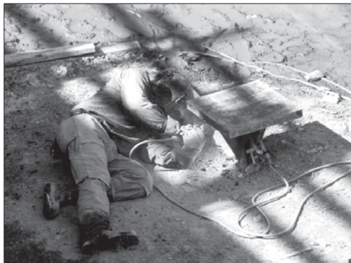
Figur 3.40 Ogenomtänkt placering av svetsfogar medför försvårat arbetsutförande.
