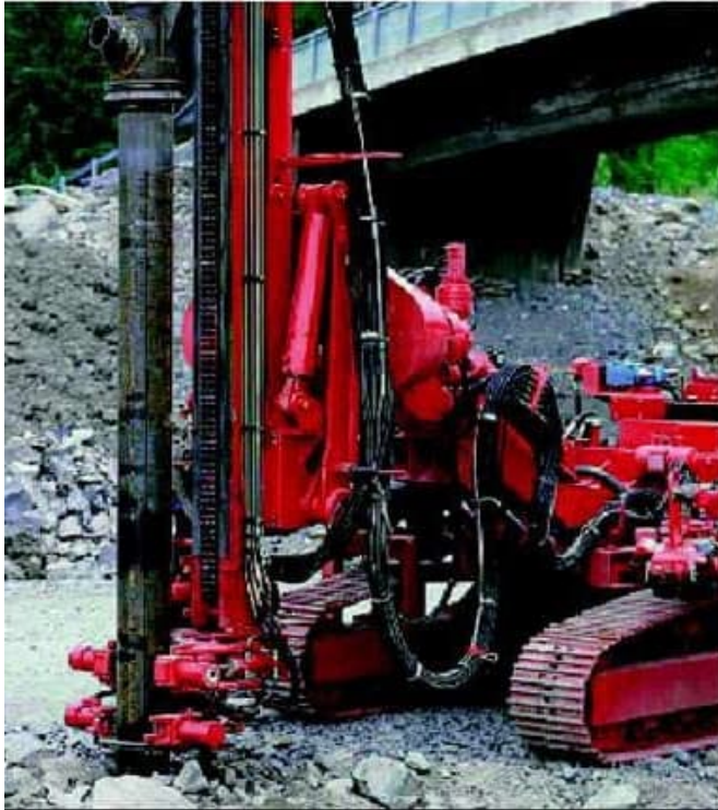
Figur 3.26 Installation av borrade stålrörspåle.
