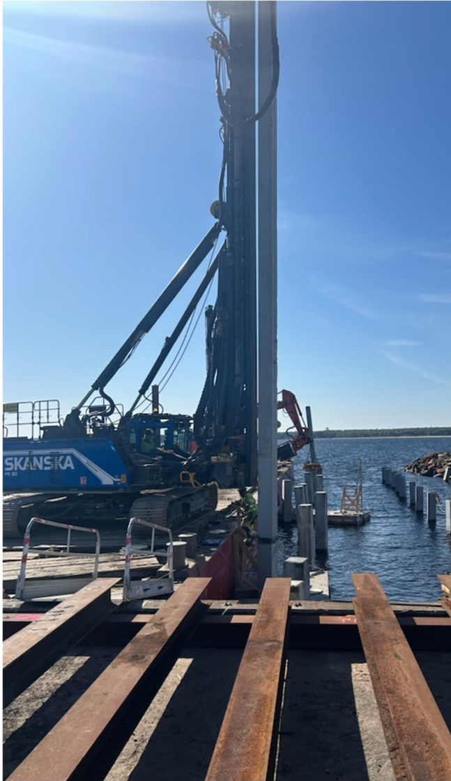
Figur 3.10 Pålning med prefabricerade betongpålar för kaj.
