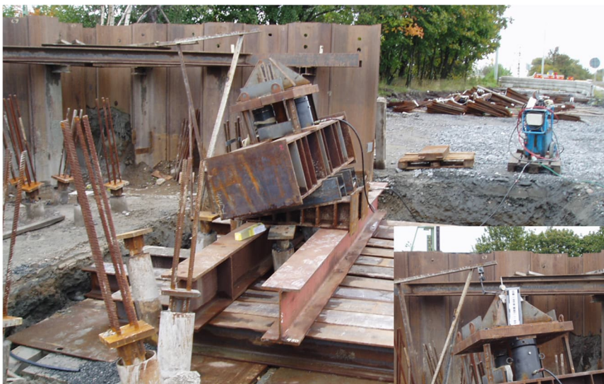
Figur 3.34 Exempel på statisk provbelastning av stålkärnepåle.
