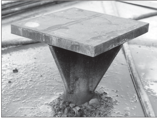
Figur 3.38 Platta vid stålkärna, enbart tryckkraft.
