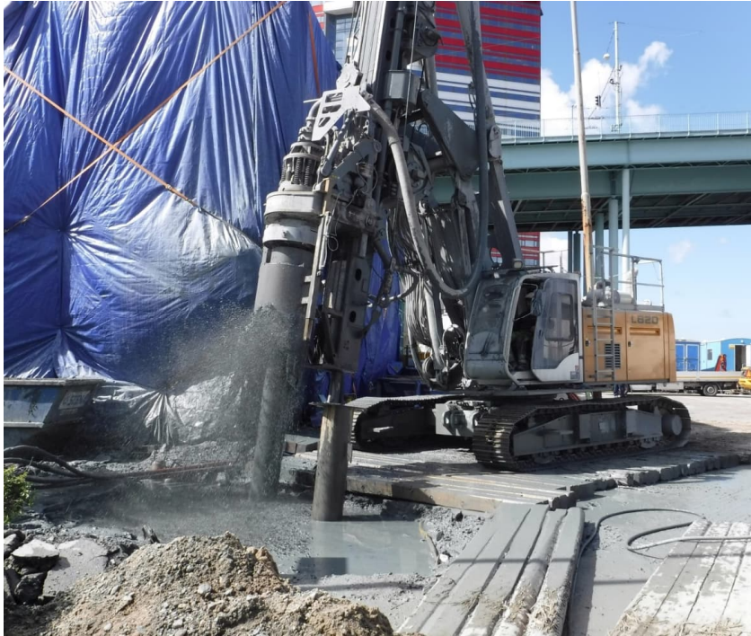
Figur 3.31 Installation av borrad, grov stålörspåle.
