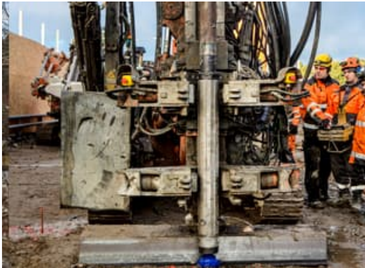
Figur 3.30 Installation av borrarad, slank stålrörspåle.
