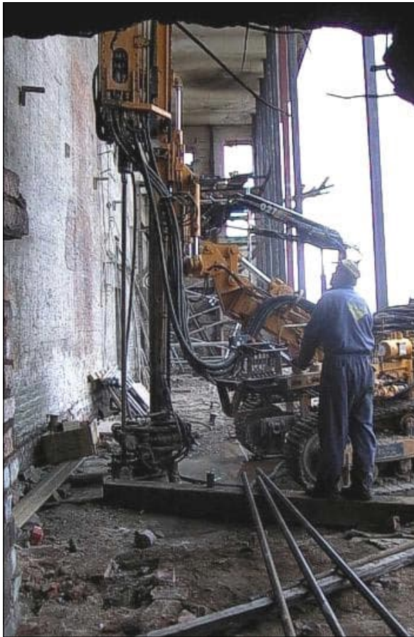
Figur 3.42 Installation av borrade, injekterade pålar.
