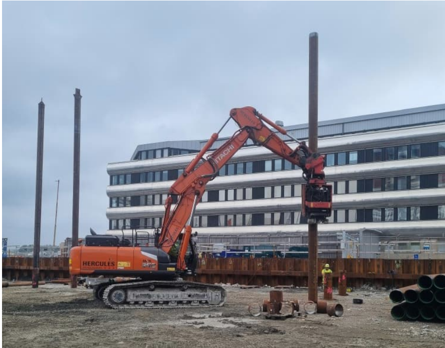
Figur 3.47 Movaxvibrator för vibrering av pålar i lera.
