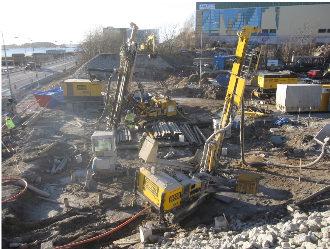
Figur 1.15 Installation av borrade slanka stålrörspålar.
