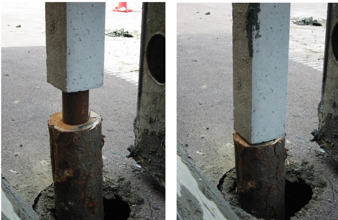
Figur 1.11 Kombipålar, betongpåleled skarvas till träpåle.
