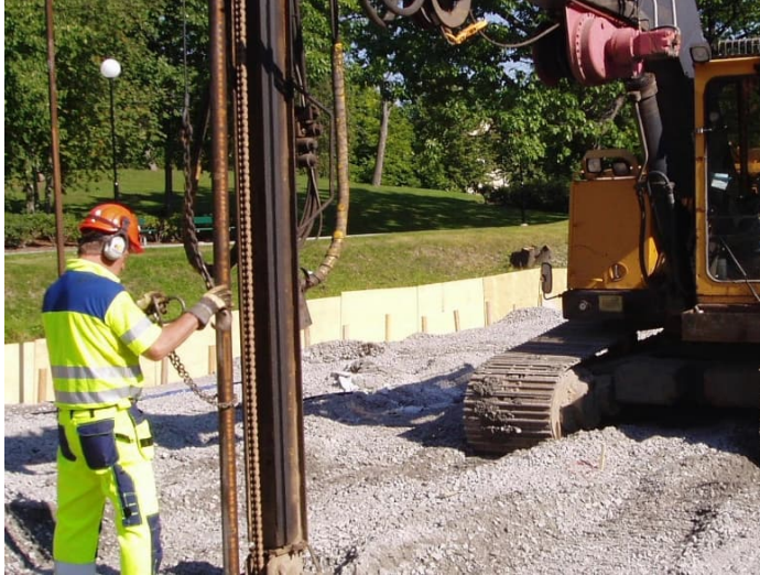
Figur 1.12 Installation av stålrörspåle med mindre dimension.
