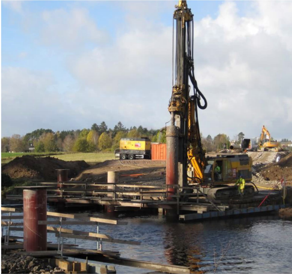
Figur 1.16 Installation av borrade grova stålörspåle (Styrud).
