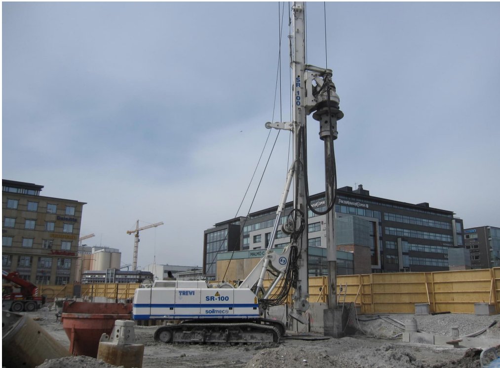
Figur 1.19 Borrutrustning för installation av grävpålar i Malmö.
