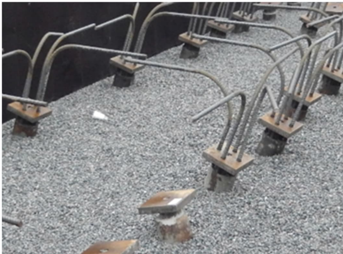
Figur 1.17 Stålkärnepålar avsedda för både tryck och dragkrafter är försedda med topplatta och förankringsjärn.
