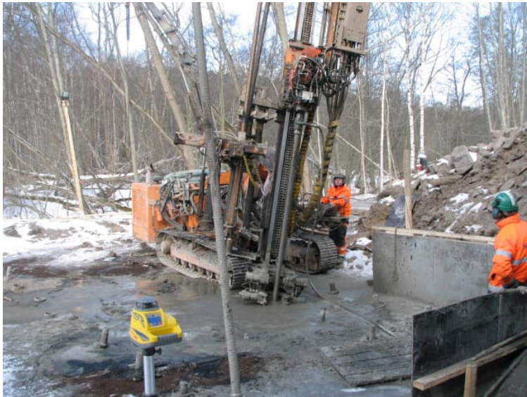
Figur 1.18 Installation och provbelastning av borrarad injekterad påle.
