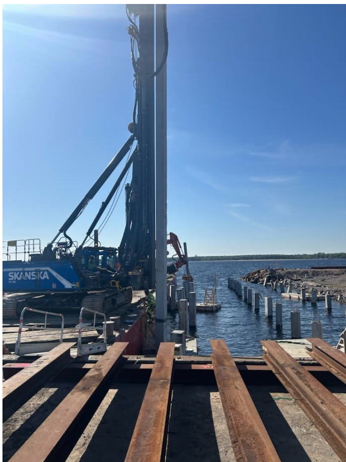
Figur 1.7 Pålning med prefabricerade betongpålar.
