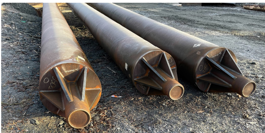
Figur 1.13 Grov stålrörspåle (610 mm) med bergsko.
