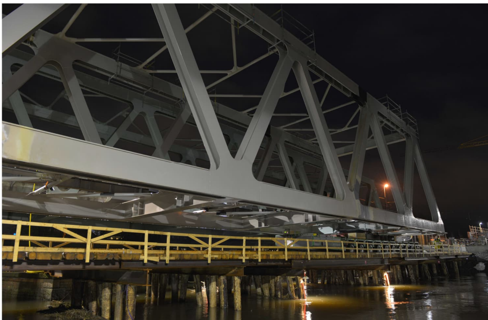
Figur 1.9 Pålbygga grundlagd på träpålar, för lansering av tunga konstruktioner.
