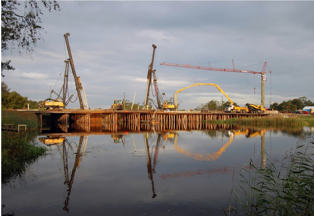
Figur 1.8 Pålbygga grundlagd på träpålar för användning som arbetsbrygga för pålning och betongarbeten.
