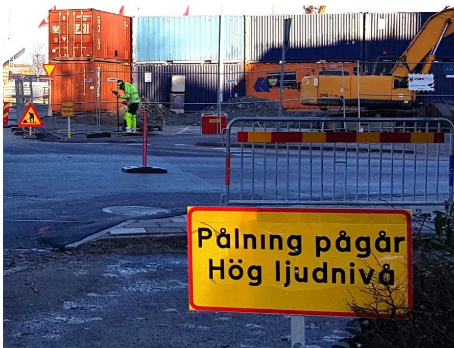
Figur 10.6.2 Bild från ett pålningsarbete med varningsskylt om höga ljudnivåer kan förekomma. Bakgrunden syns även containrar som används för att både minska bullernivån för omgivningen och för att skydda tredje man för om en pålkran skulle välta.
