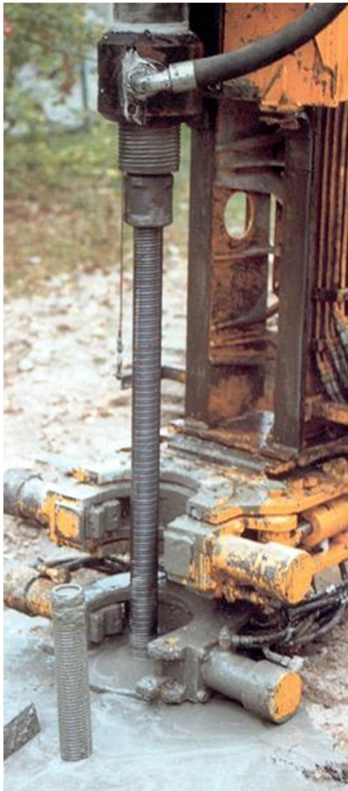
Figur 3.41 Installation av borrad injekterad påle utförs under kontinuerlig injektering av cementbruk. Injekteringstryck och tillförsel av cementbruk styrs för att erhålla en betongkropp runt stålpålen.
