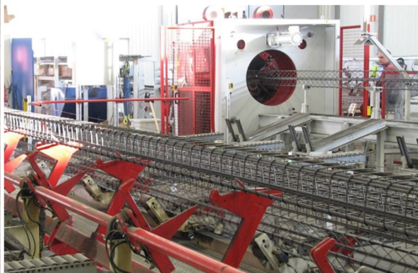
Figur 3.15 Svetsad armeringskorg intill svetsrobot.
