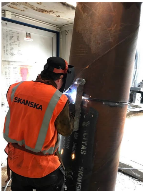
Figur 3.22 Skarvning av grov stålrörspåle med svetsning.
