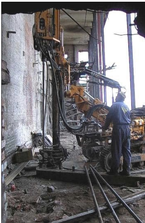
Figur 3.42 Installation av borrarad, injekterad pÅle.
