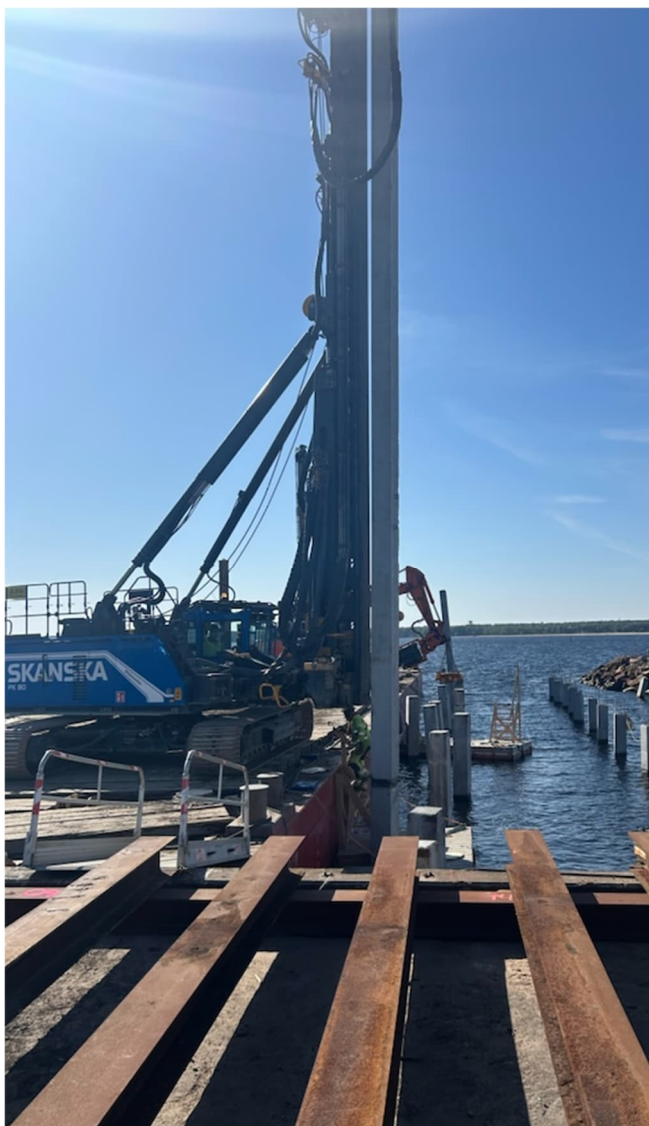
Figur 3.10 Pålning med prefabricerade betongpålar för kaj.
