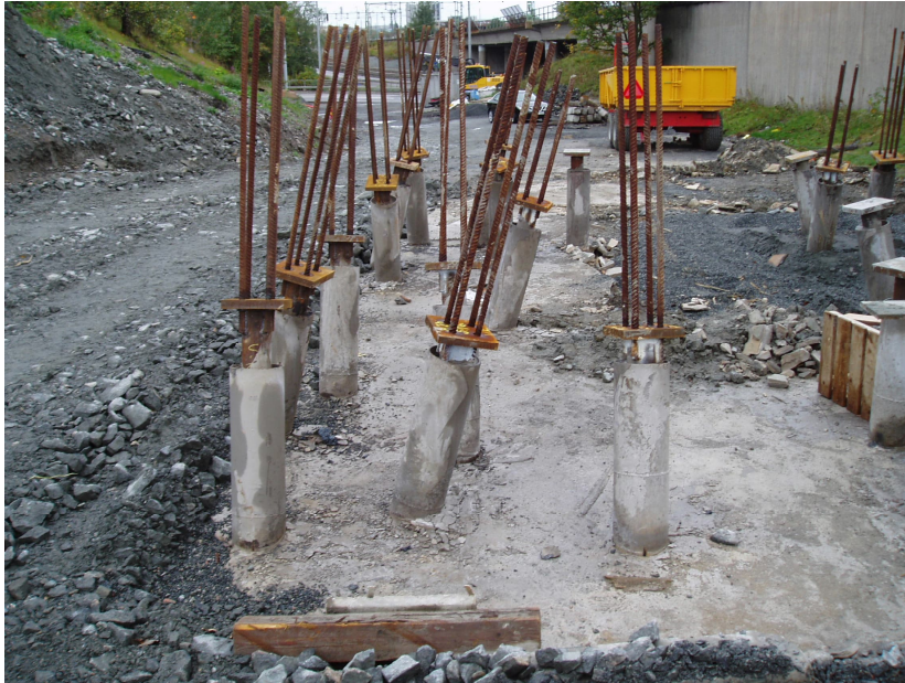
Figur 3.33 Stålkärnepålar avsedda för både tryck och dragkrafter är försedda med topplatta och förankringsjärn. I figuren syns också några stålkärnepålar med enbart topplatta, avsedda för enbart tryckkrafter.
