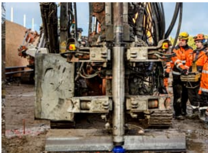
Figur 3.30 Installation av borrarad, slank stålrörspåle.
