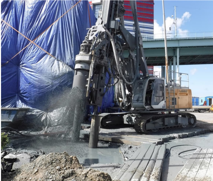
Figur 3.31 Installation av borrarad, grov stålörspåle.
