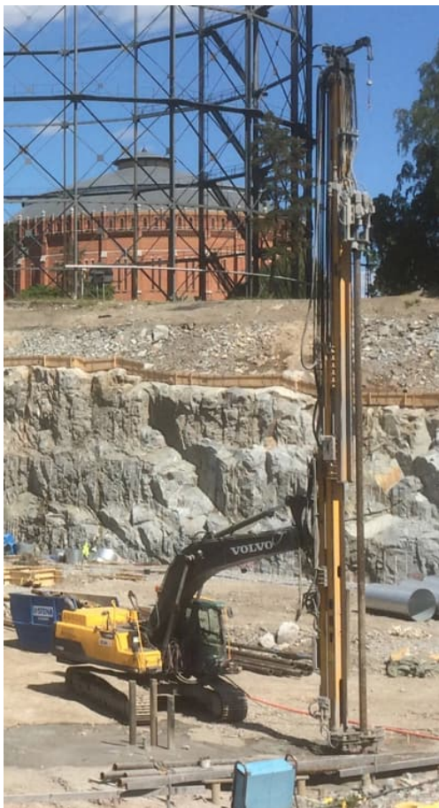
Figur 3.20 Installation av stålrörspåle <170 mm.
