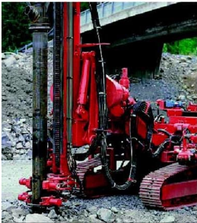
Figur 3.26 Installation av borrade stålrörspåle.
