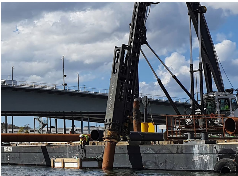
Figur 3.21 Installation av slagen stålrörspåle från ponton.
