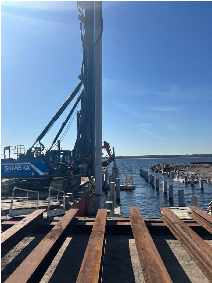
Figur 1.7 Pålning med prefabricerade betongpålar.
