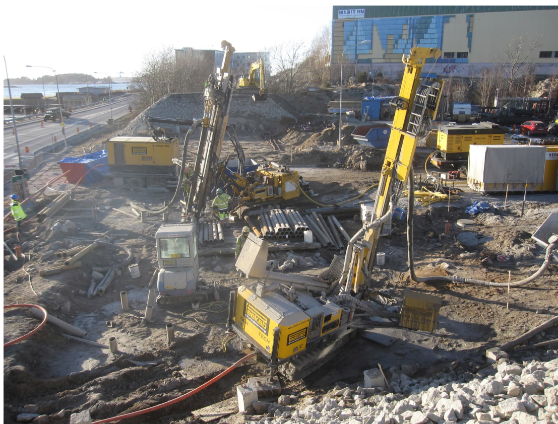
Figur 1.15 Installation av borrade slanka stålrörspålar.
