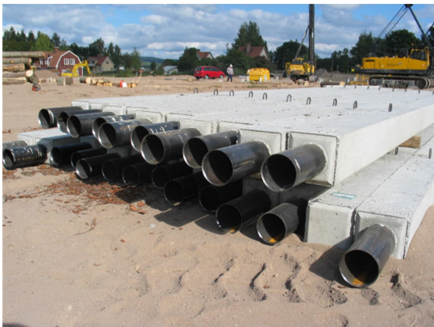
Figur 1.10 Betongpålar med ingjutna skarvhylsor för skarvning till träpåle.
