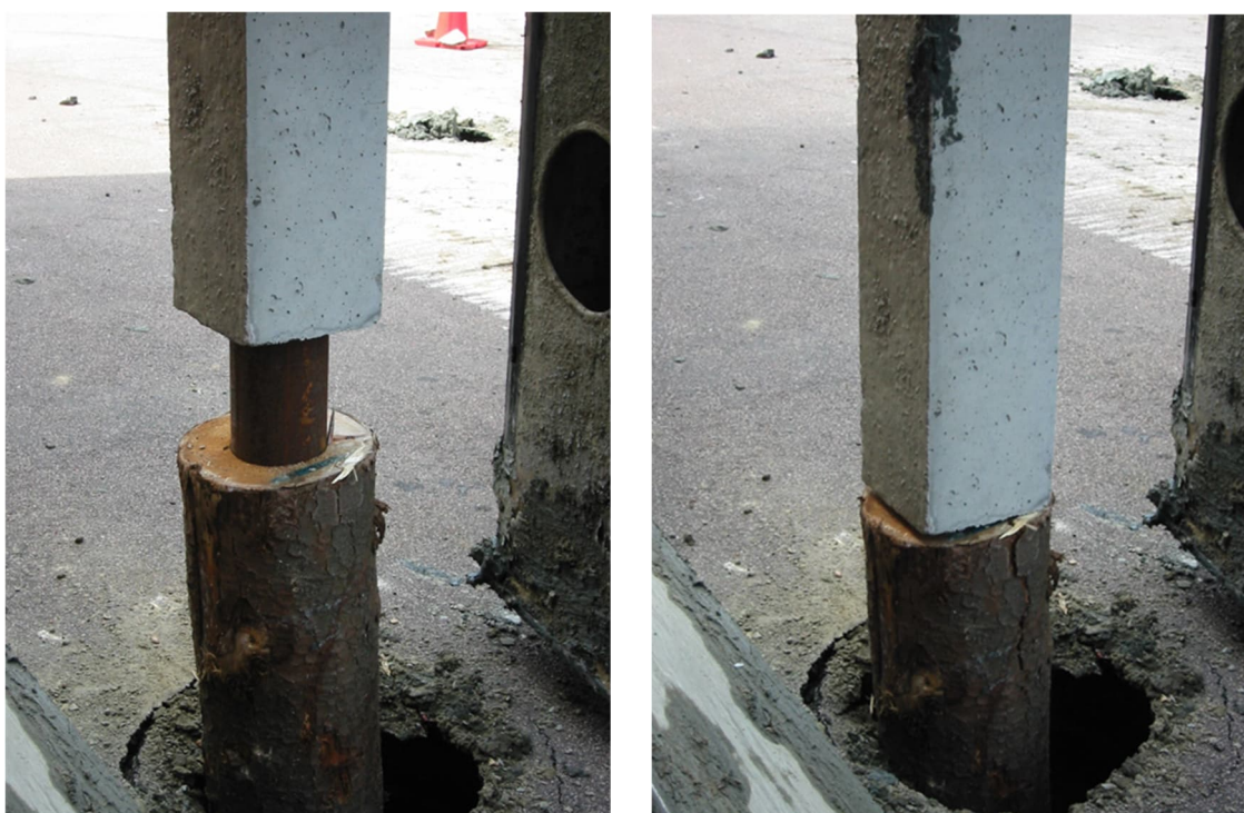
Figur 1.11 Kombipålar, betongpåleledel skarvas till träpåle.
