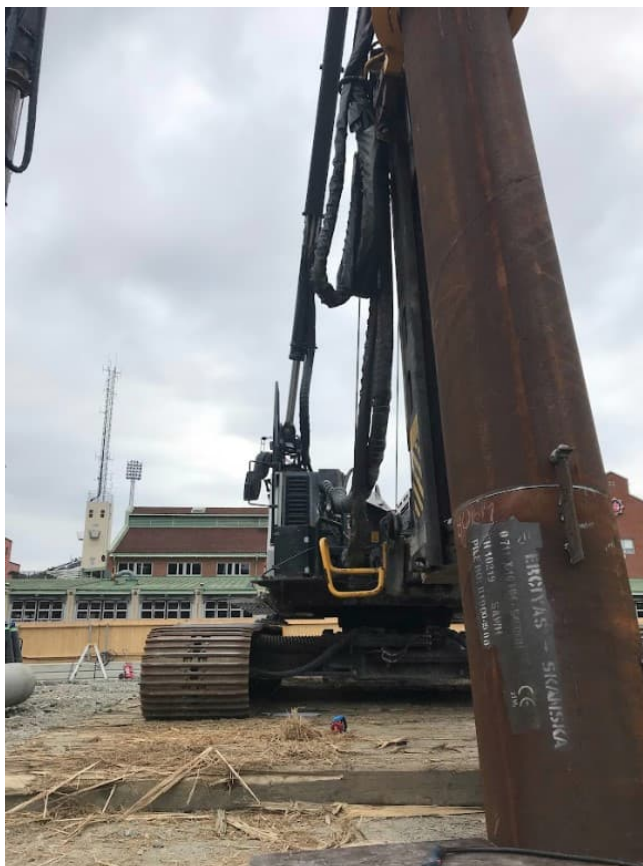
Figur 1.14 Överst: Installation av slagen stålrörspåle från pålbrygga. Underst: Installation av slagen stålrörspåle vid CityGate.
