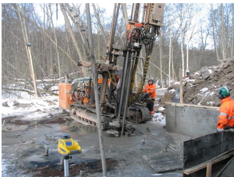
Figur 1.18 Installation och provbelastning av borrarad injekterad påle.
