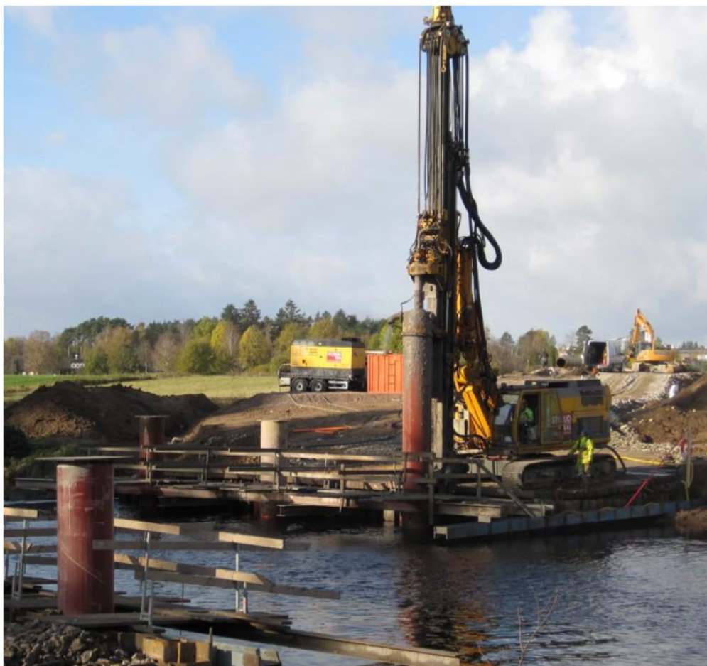
Figur 1.16 Installation av borrade grova stålörspåle (Styrud).
