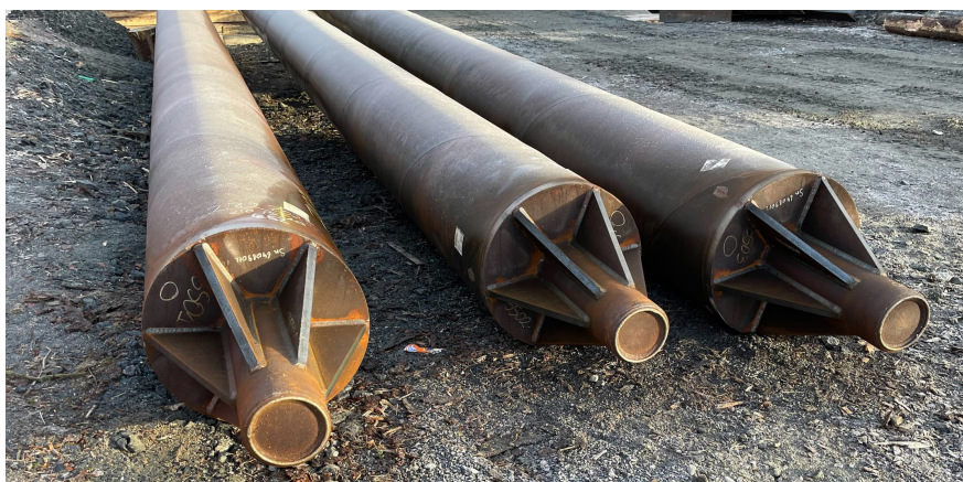
Figur 1.13 Grov stålrörspåle (610 mm) med bergsko.
