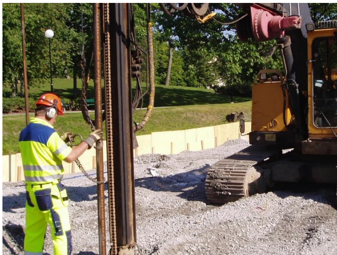
Figur 1.12 Installation av stålrörspåle med mindre dimension.
