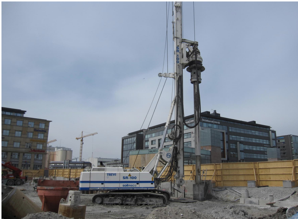
Figur 1.19 Borrutrustning för installation av grävpålar i Malmö.
